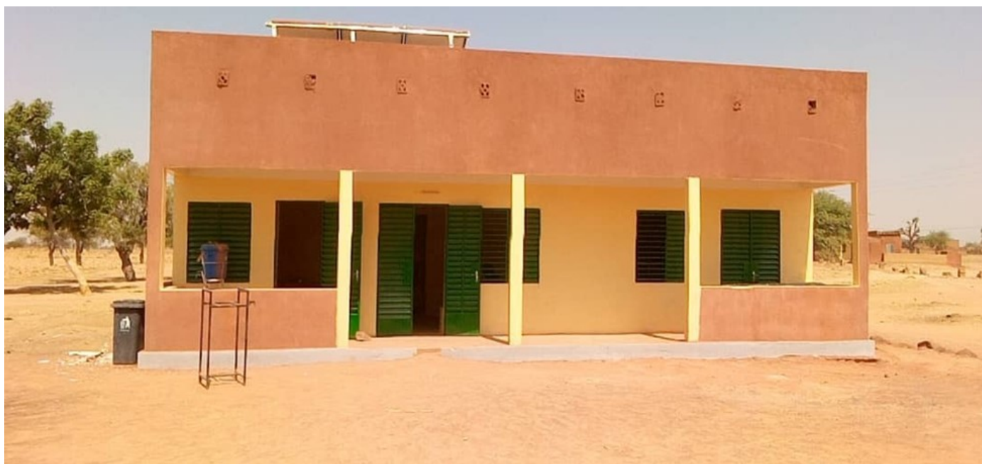
Réfection du Centre de santé communautaire de Kain
