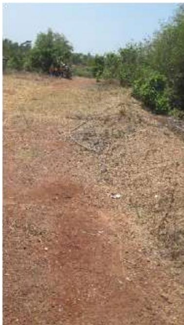
Digue combinée réalisée entièrement en latérite par une entreprise mécanisée
