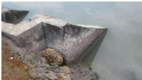
Ouvrage réalisé en deux parties : la première ayant un béton de qualité, la deuxième des glissières pour des batardeaux fortement corrodés par l'eau de mer.
