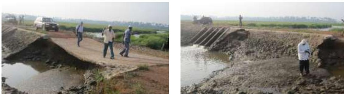
Des dépôts de matériaux (forme de renardage) au raccordement avec l'ouvrage et ancien corps de digue, mettant en péril la digue route.
