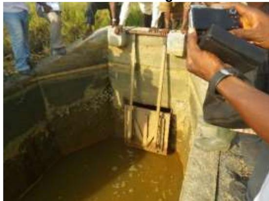
Ouvrage en bon état de fonctionnement avec vanne à clapet côté mer.
