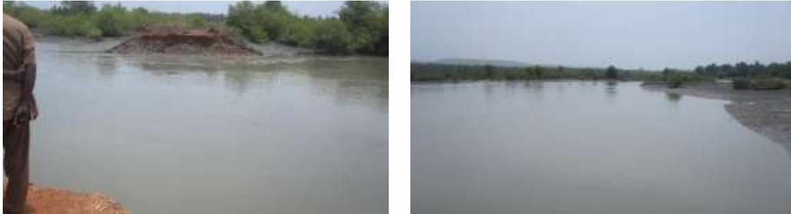
Digue ceinture du bloc 3 emportée au niveau du cours d'eau principale      Vue du bloc 3 en amont de la digue de ceinture
