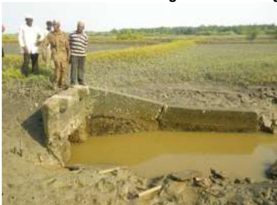
Ouvrage manquant du ferrailage, cause de sa destruction
